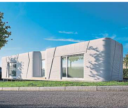
3D TISK BETONU DŘÍVE EXPERIMENT DNES ZKRACUJE VÝSTAVBU A ŠETŘÍ NÁKLADY.
