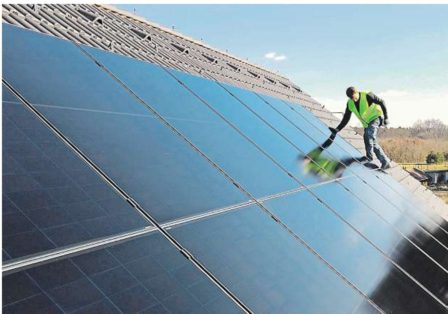
POKUD UVAŽUJETE DO BUDOUCNA O FOTOVOLTAICE, JE VHDNÉ TOMU PŘÍZPŮBIT UŽ NÁVRH STŘECHY. FOTO: KM BETA
