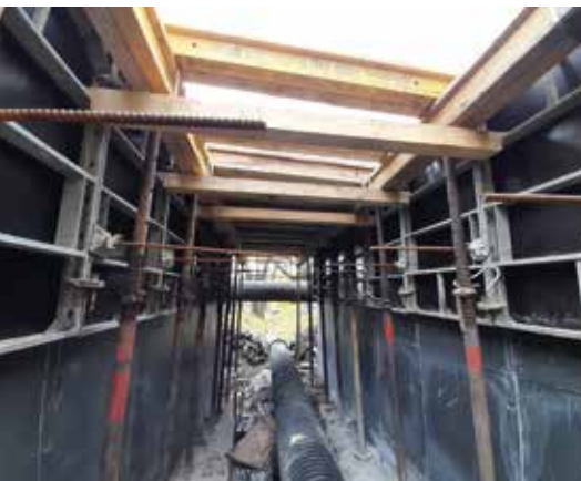
7 Podélný řez 8 Čelní pohled na původní opěru po odstranění nosné konstrukce a přípravě povrchu pro žebrovou UHPC přibetonávku 9 Půdorys opěry s žebrovou UHPC přibetonávku 10 Zkušební žebro z UHPC 11 Pohled na původní opěru se svislými drážkami a betonářskou výztuží před realizací UHPC přibetonávky 12 Provádění přibetonávky z UHPC 13 Dokončená UHPC přibetonávka s rozšiřujícím žebrem na horním okraji, příčným táhlem mezi konci křídel a s vyčnívající betonářskou výztuží pro provázání s novou železobetonovou polorámovou nosnou konstrukcí 14 Povrch UHPC přibetonávky po odbednění 15 Most v Meziboří po rekonstrukci
