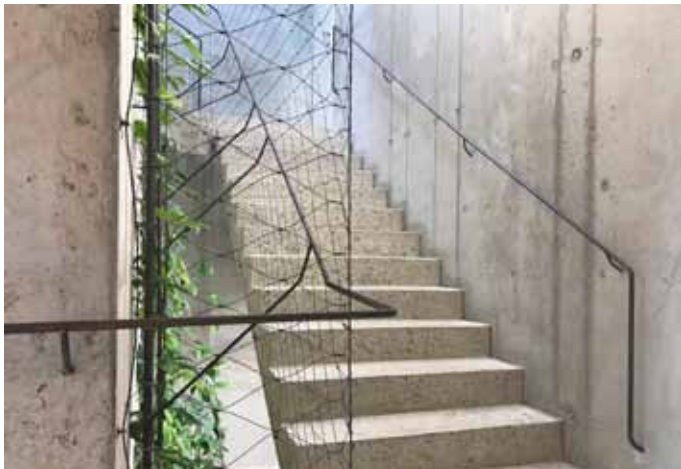
Šporkovský palác – schody z bílého betonu
