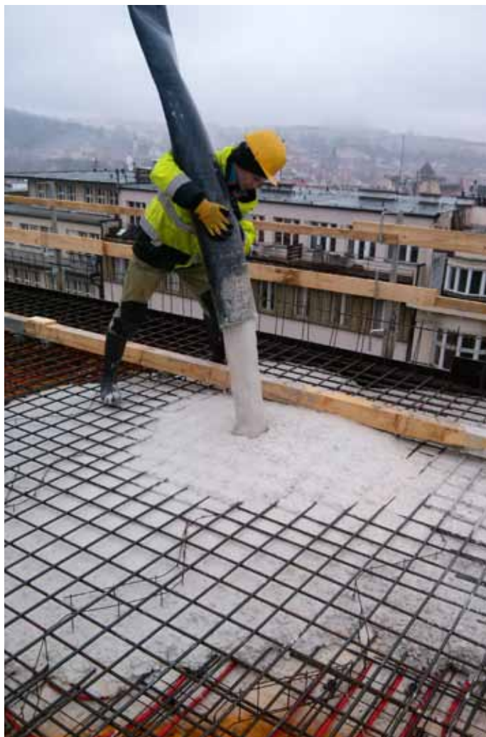
Palác DRN – betonáž bílého stropu
