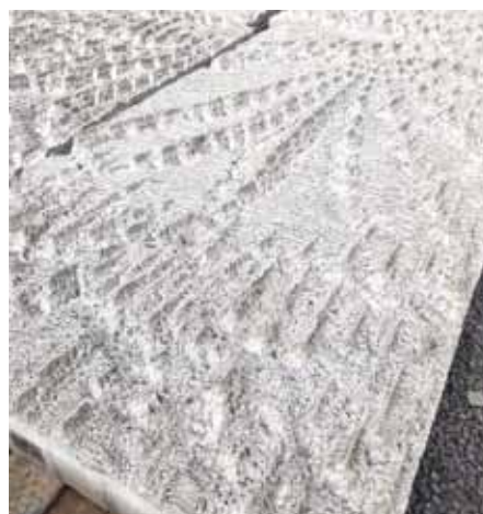
Segmenty z bílého betonu pro opláštění výdechu z tunelu Blanka
