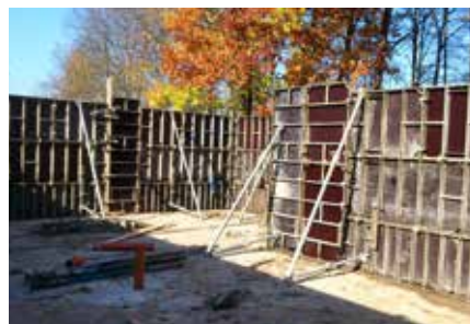
Ošetřování stěn Doporučená doba odbednění konstrukcí bílých van je dle TP ČBS 02 minimálně 36 hodin. Při kratších odbedňovacích lhůtách je nutné započít maximálně do 1 hodiny po odbednění s účinným ošetřováním.
