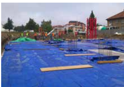
Ošetřování desky Povrch hotových vodonepropustných konstrukcí je nutné začít ošetřovat neprodleně po uložení betonu s ohledem na snížení rizika vzniku trhlin. Všeobecně platí, že čím déle je beton ošetřován, tím lépe, nejméně však 7 dní.
