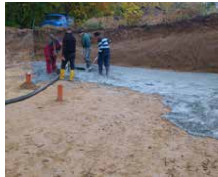
Příprava podkladu pod bílou vanu Realizace podkladních betonů je nutná jako ochrana základové spáry před povětrnostními vlivy po dobu přípravy betonáže základové desky. Pro realizaci podkladních betonů se běžně používá beton pevnostní třídy C12/15 nebo nižší.
