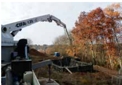
Betonáž stěn Při betonáži stěn je nutné (stejně jako u běžných konstrukcí) zabránit padání betonu z velké výšky. Se zvyšující se výškou padání betonu roste riziko rozdělení betonu a tvorba hnízd. Vibrace se provádí běžnými ponornými vibrátory a intenzita musí být přizpůsobena konzistenci betonu.
