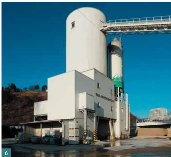
Obr. 6 Betonárna v Praze-Troji s instalovaným chladičím zařízením na ledovou vodu ■ Fig. 6 Concrete plant in Prague-Troja with installed cooling system for cold water
