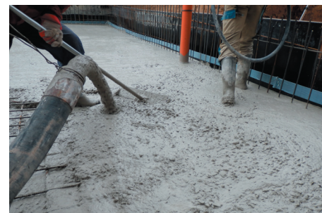
▲ Obr. 3. Ukládka betonu Pemacrete®
