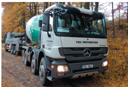
▲ Obr. 2. Doprava a čerpání betonu
