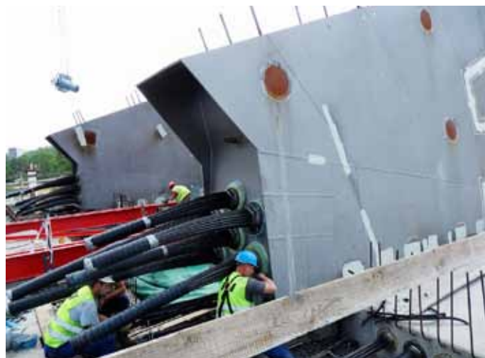
Obr. 7: Předpínání kabelů v místě ocelobetonového zárodku (beton C80/95 – 90 dní)
