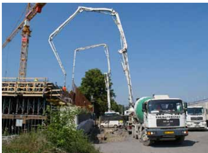
Obr. 2-4: Čerpání a ukládání betonu
