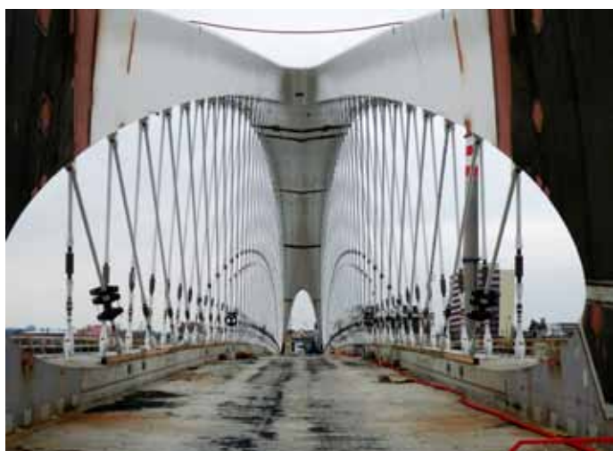
Obr. 10, 11: Dokončený nosný oblouk se závěsnými lany
