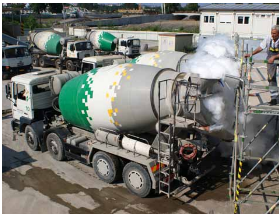
Obr. 1: Chlazení čerstvého betonu C50/60 XF2 kapalným dusíkem
