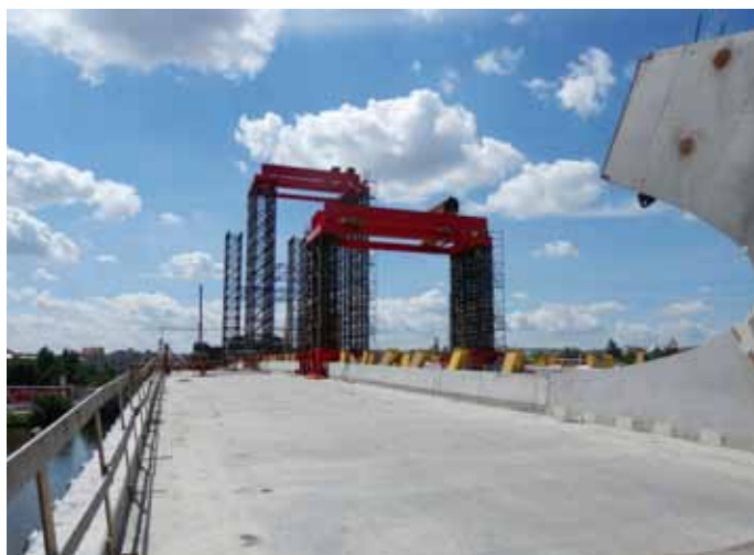
Obr. 6: Vybetonovaná mostovka a táhlo s provizorními podpěrami nosného oblouku
