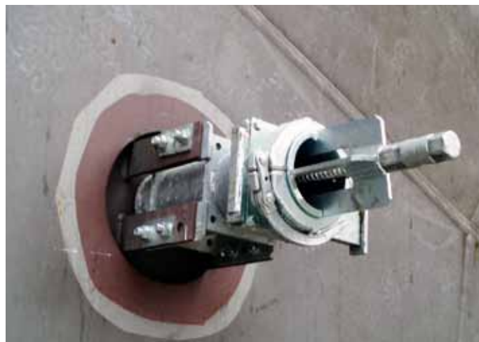
Obr. 5: Systém uzavření napouštěcího otvoru pro čerpání betonu do zárodku
