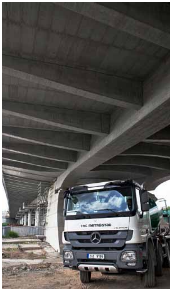
Obr. 4: Trojský most, mostovka z betonu C50/60 XF2
