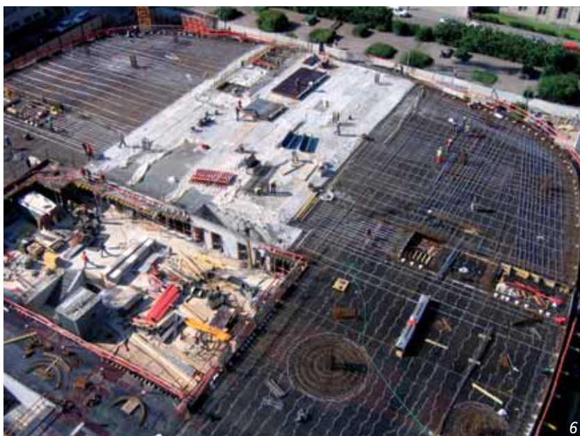
Obr. 6 Dokončený díl 1, probíhá ukládka dílu 2
