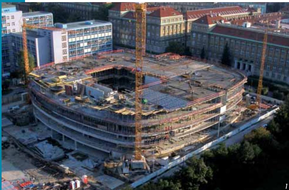
Obr. 1 Pohled na rozestavěnou budovu knihovny
