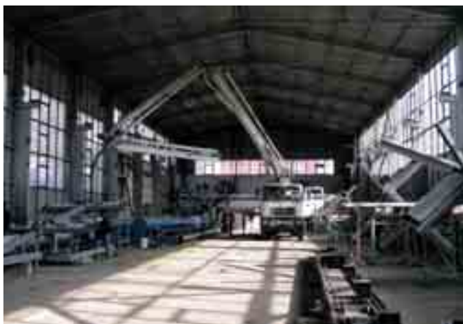
Obr. 2 Betonáž ocelobetonových sloupů z vysokopevnostního SCC betonu Fig. 2 Concreting of steel concrete columns from high-strength SCC concrete
