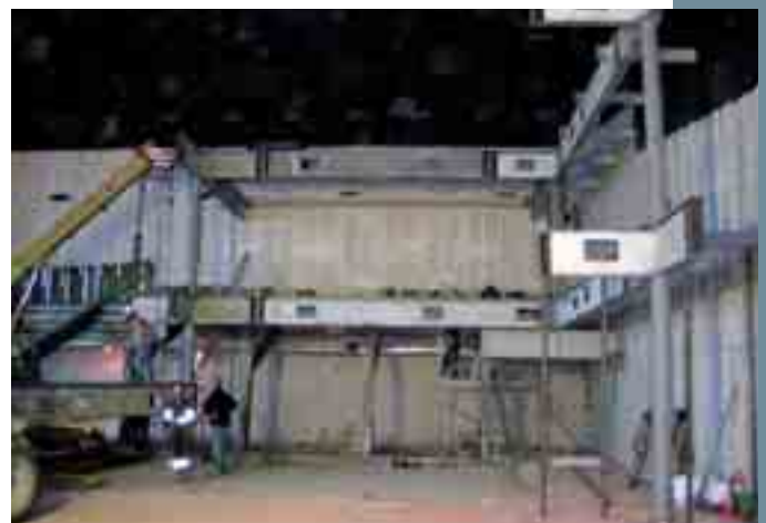
Obr. 3 Montáž prefabrikované nosné konstrukce Fig. 3 Assembly of a prefabricated carrying structure
