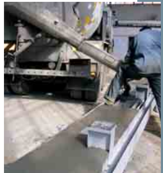
Obr. 1 Betonáž prefabrikovaného průvlaků Fig. 1 Concreting of a prefabricated girder
