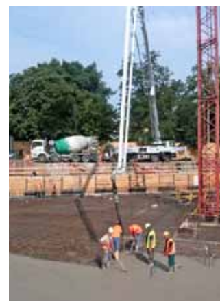
Betonáž novostavby v ulici U Uranie v Praze 7
