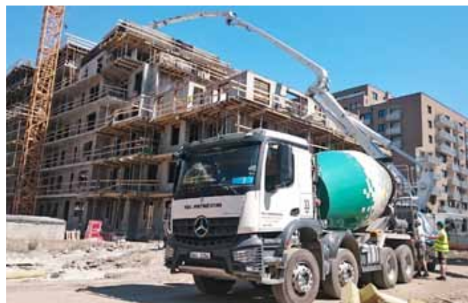
Betonáž BD Tulipa Třebešín
