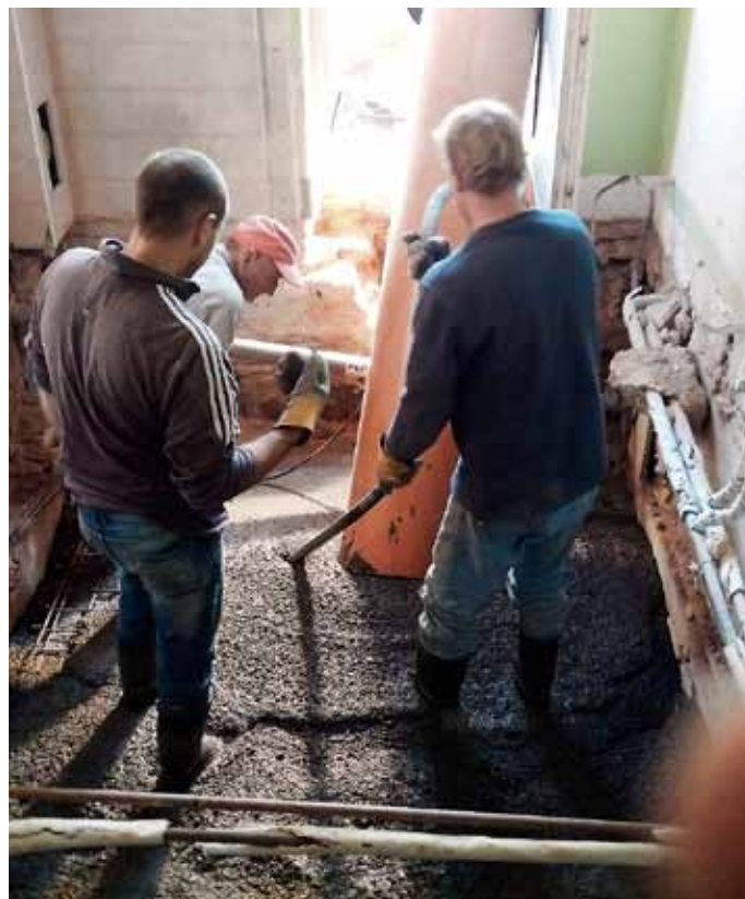
Obr. 9: Betonáž 2. etapy stropní konstrukce
