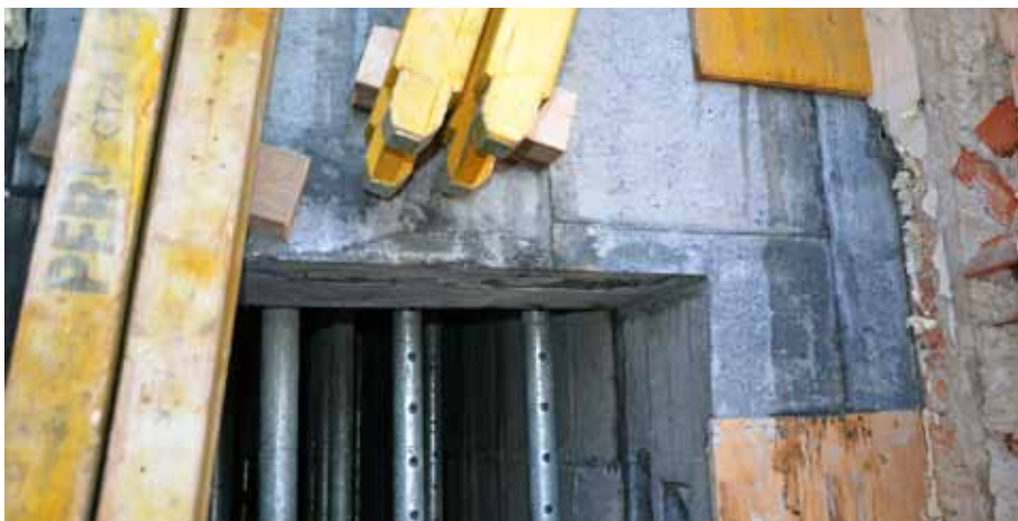
Obr. 11: Detail odbedněné konstrukce z těžkého betonu
