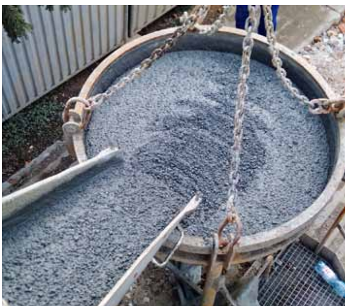
Obr. 4, 5: Plnění bádie z autodomíchávače
