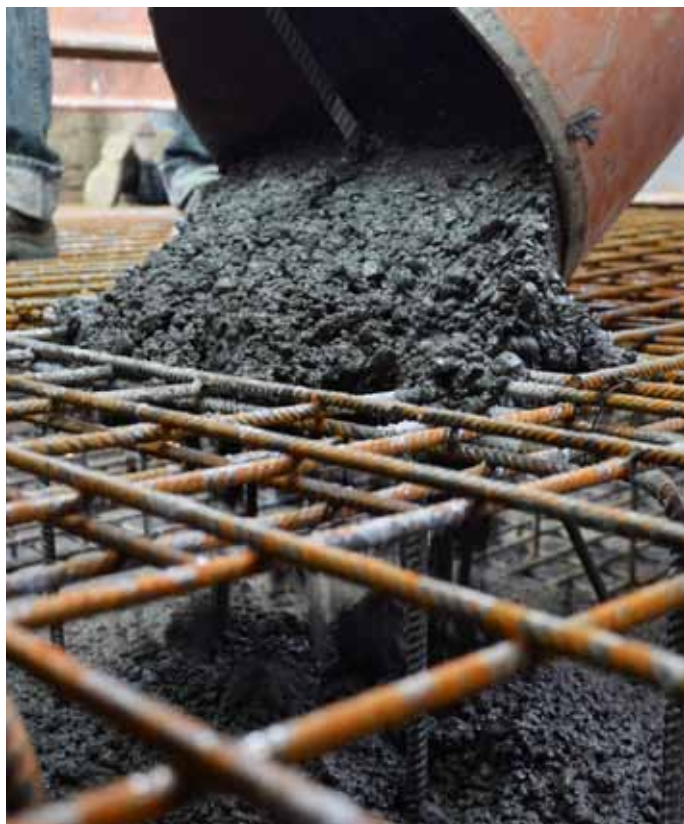
Obr. 8: Detail na plnění stropní desky betonem
