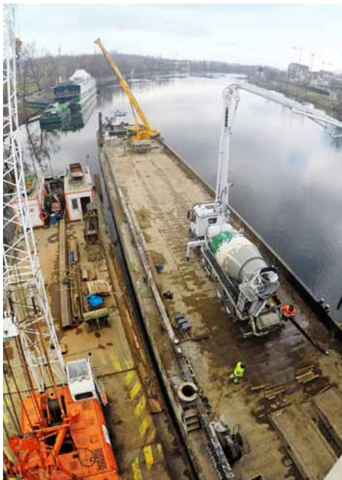
Příprava hadic na ukládku betonu
