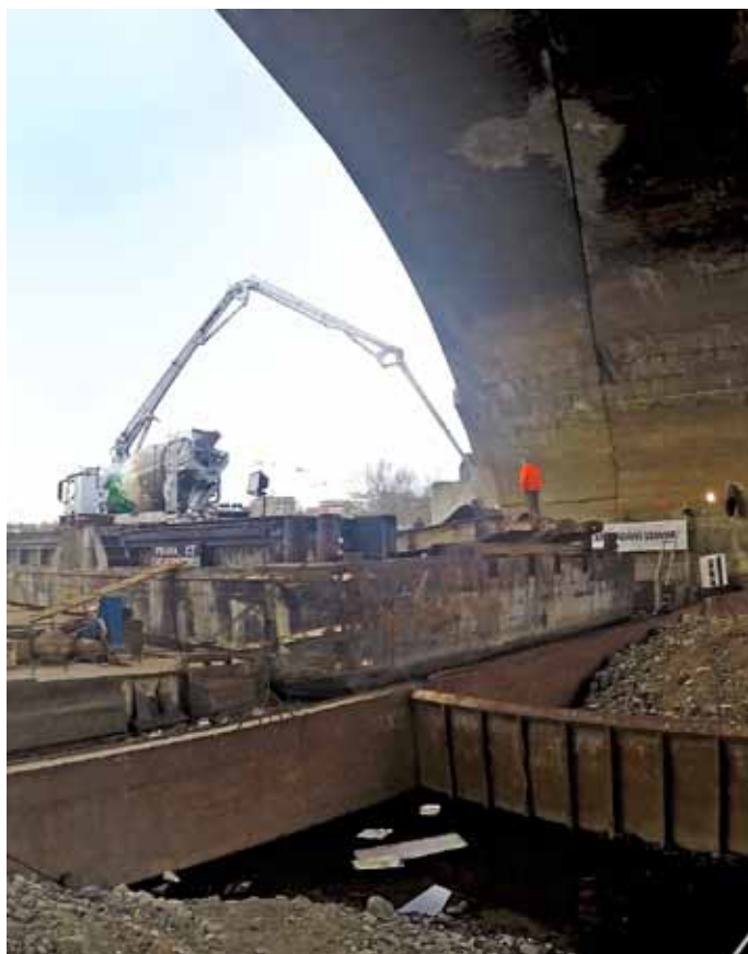
Ukládka betonu
