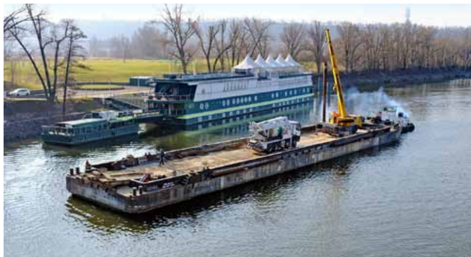
Transport autodomíchávače s betonem lodí k Libeňskému mostu
