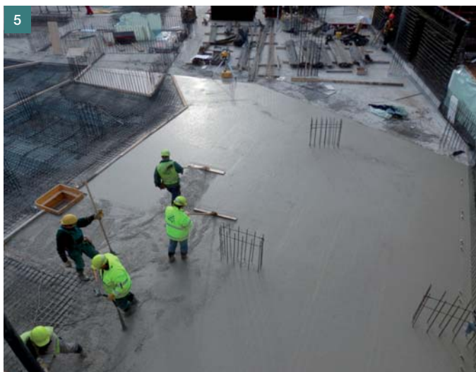
Obr. 4 Ukládka betonu základové desky bílé vany ■ Fig. 4 Concrete placing to base slab of white tank
