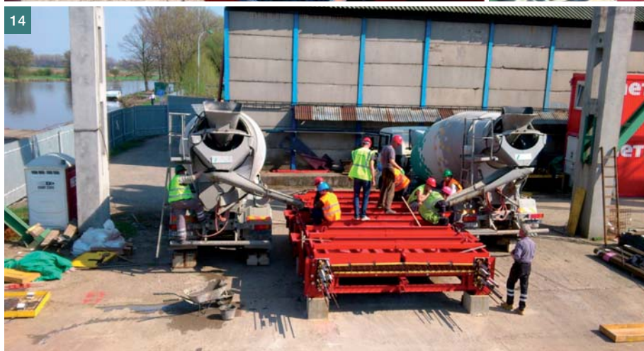
Obr. 13 Plnění formy betonem UHPC ■ Fig. 13 Pouring of UHPC into the mould
