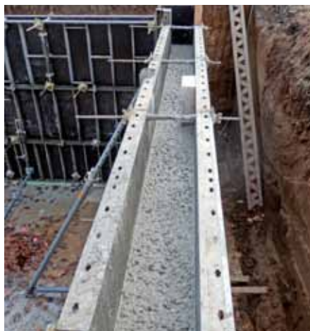
Obr. 2: Zabetonovaná stěna z PERMACRETU
