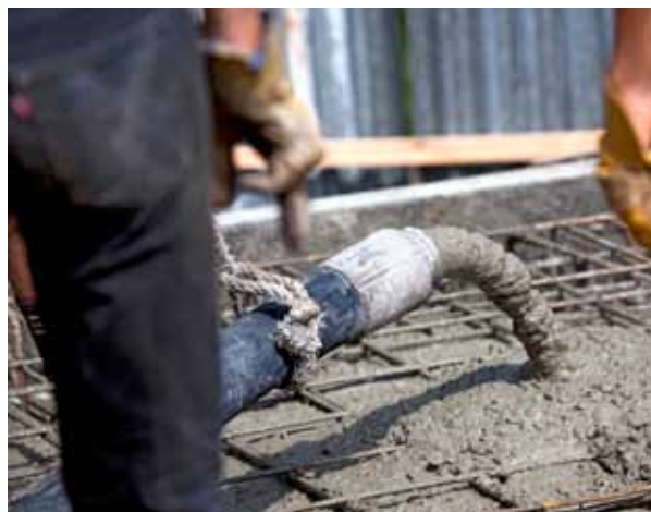
Obr. 1: Ukládka PERMACRETU do základové desky
