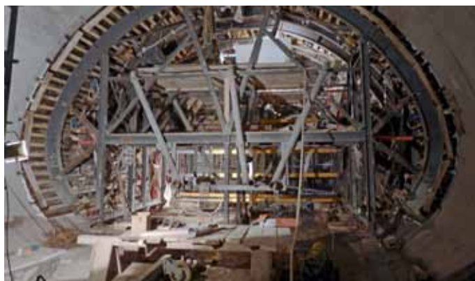
Obr. 4: PERMACRETE ve vodonepropustném definitivním ostění vzduchotechnického kanálu MYPPA
