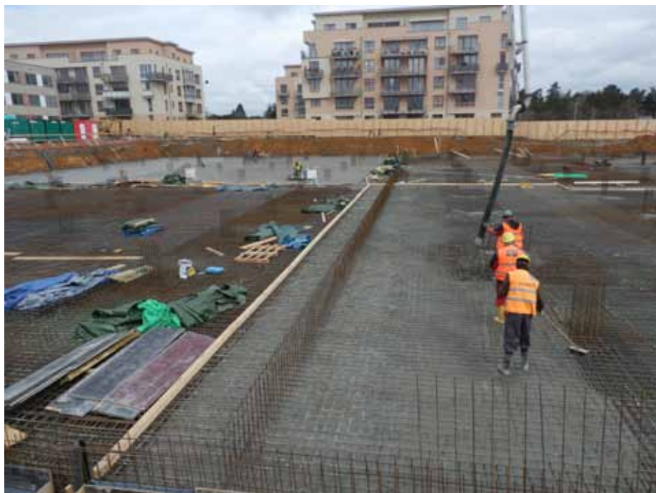
Obr. 7: Betonáž vodonepropustné základové desky bytového objektu
