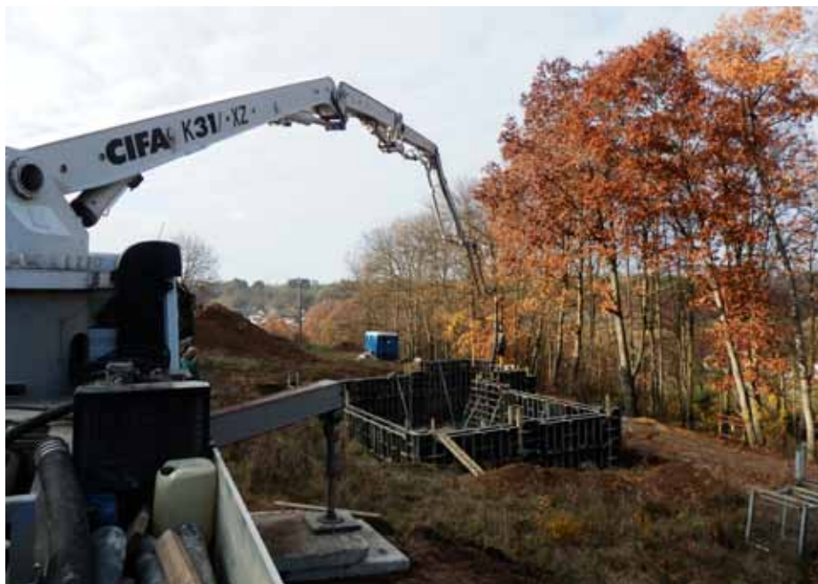
Obr. 4: Betonáž stěn bílé vany z drátkobetonu bez tuhé výztuže
