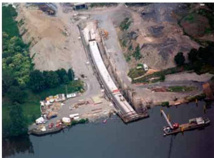
Obr. 5, 6: Plavené tunely metra v Holešovicích
