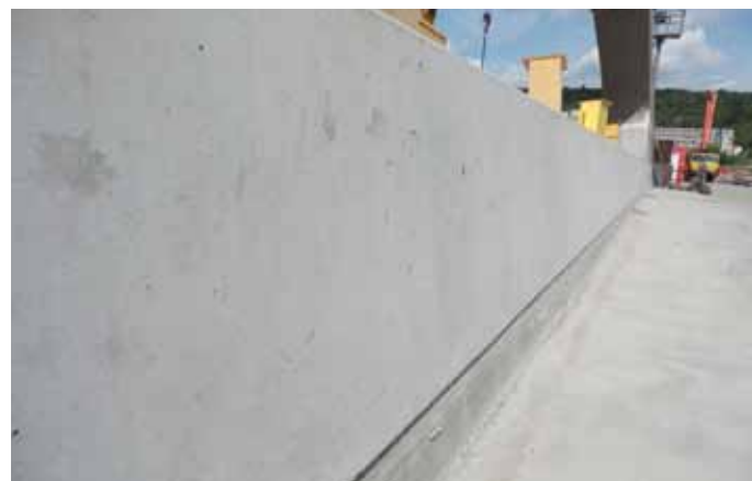
Betonová rampa oddávající tramvajový pás od pruhů pro automobily
