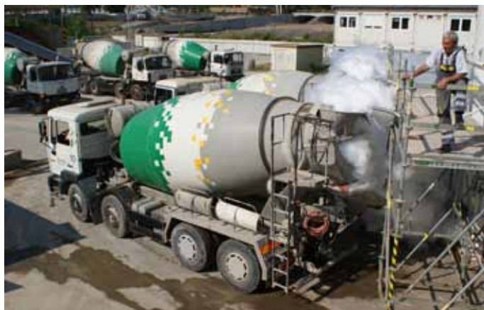
Chlazení betonu kapalným dusíkem
