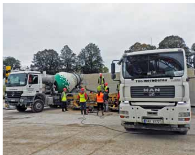
Obr. 5: Ukládka UHPC
