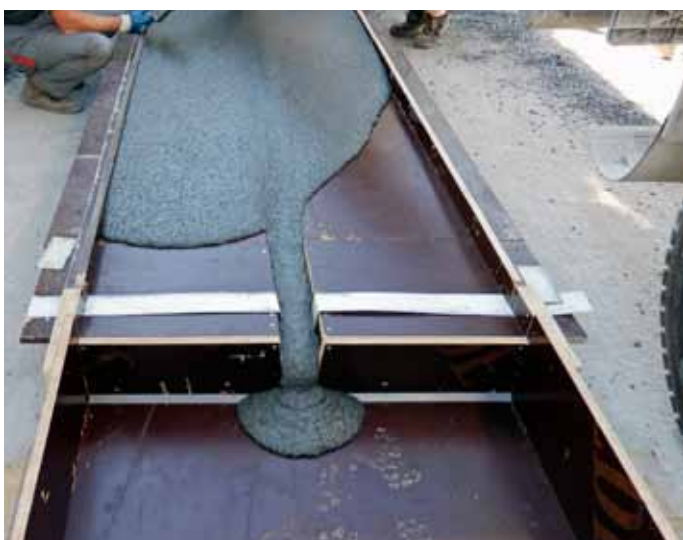
Obr. 6: Ukládka UHPC do konstrukce zároveň ze dvou automomíchávačů
