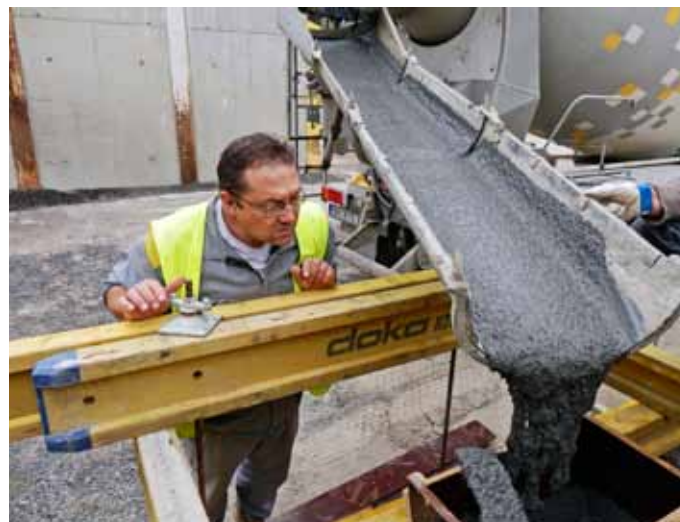
Obr. 4: Skládání betonu
