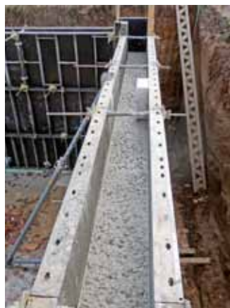
Zabetonovaná stěna z Permacretu D
