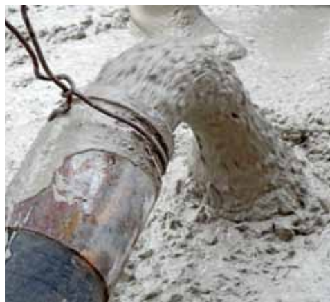
Ukládka Permacretu D do základové desky
