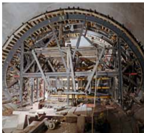
Použití Permacretu ve vodonepropustném definitivním ostění tunelů MYPRA
