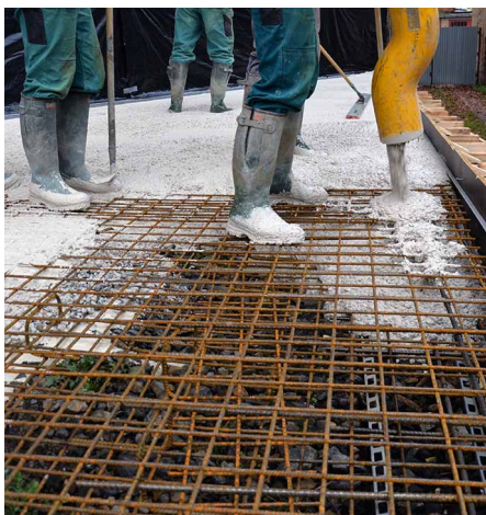
Betonáž terasy z betonu z bílého cementu v Holešovicích
