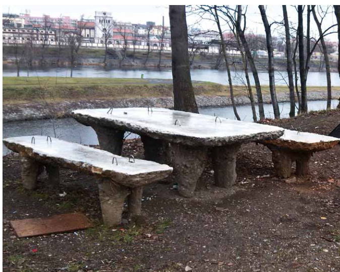
Betonáž lavičky Přístavu 18600 – beton s běžným cementem a 8 % bílého pigmentu
