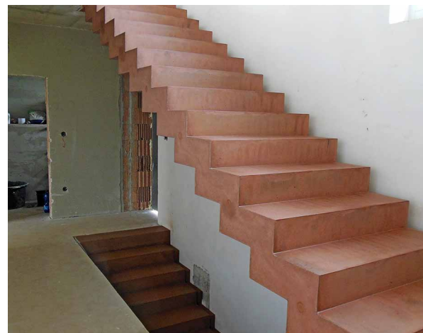
Schodiště z červeného betonu; ve spolupráci s Švec decor
