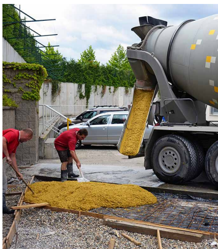
Betonáž parkovacího stání ze žlutého betonu
