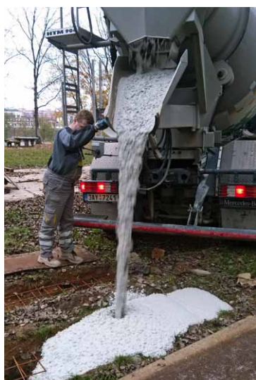
Betonáž lavičky Přístavu 18600 – beton s běžným cementem a 8 % bílého pigmentu
