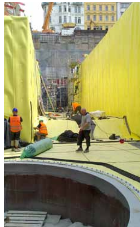
Obr. 1: Ukázka fóliové hydroizolace spodní stavby budovy Quadrio
