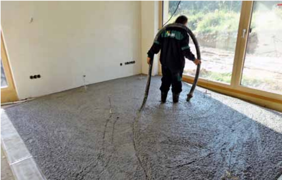
PORIMENT P 300 – zalití a ochrana rozvodů vedených v podlaze, ideální podklad pod kročejovou izolaci
