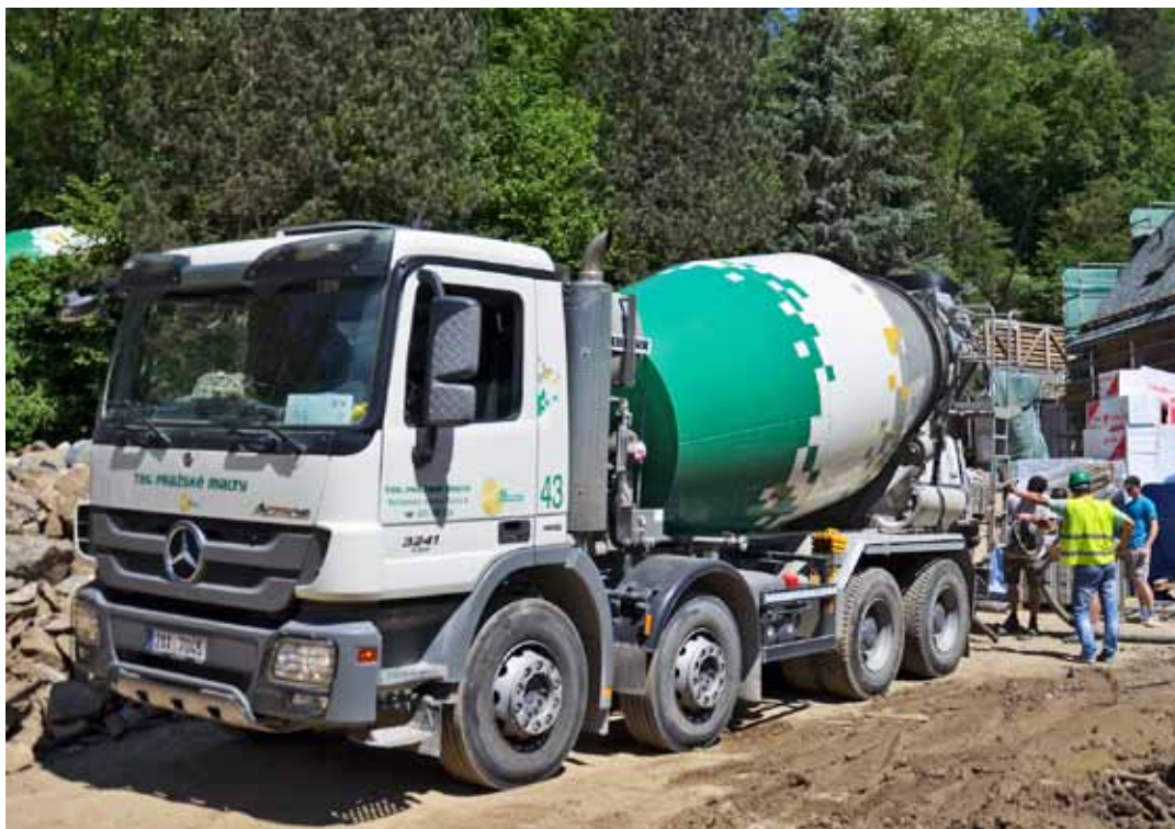
Mokrá cesta – autodomíchávače a výkonná diesellová čerpadla
