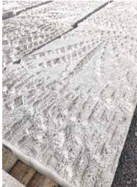
Detail struktury hotových fasádních panelů
