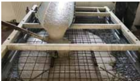
Plnění formy bílým betonem
