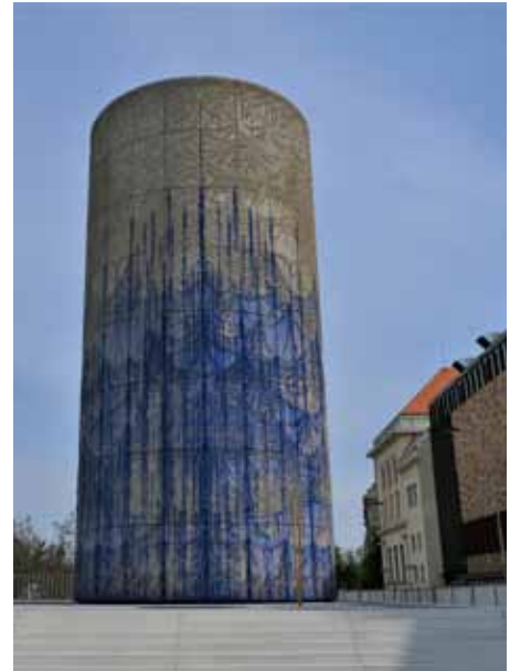
Výdech z tunelu Blanka (foto lze dle potřeby oříznout)
