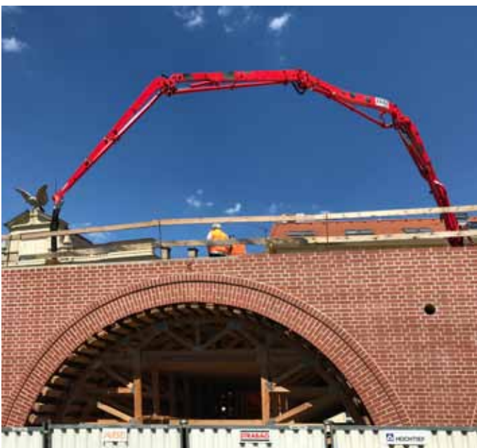
Ukládka provzdušněného betonu pevnosti C 30/37
