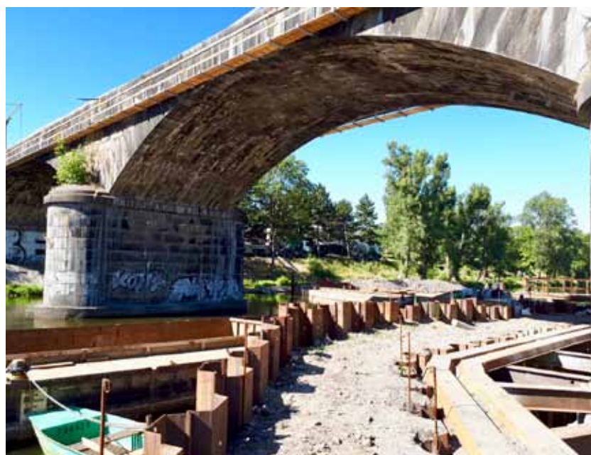
Čerpání betonu do vzdálenosti 100 m
