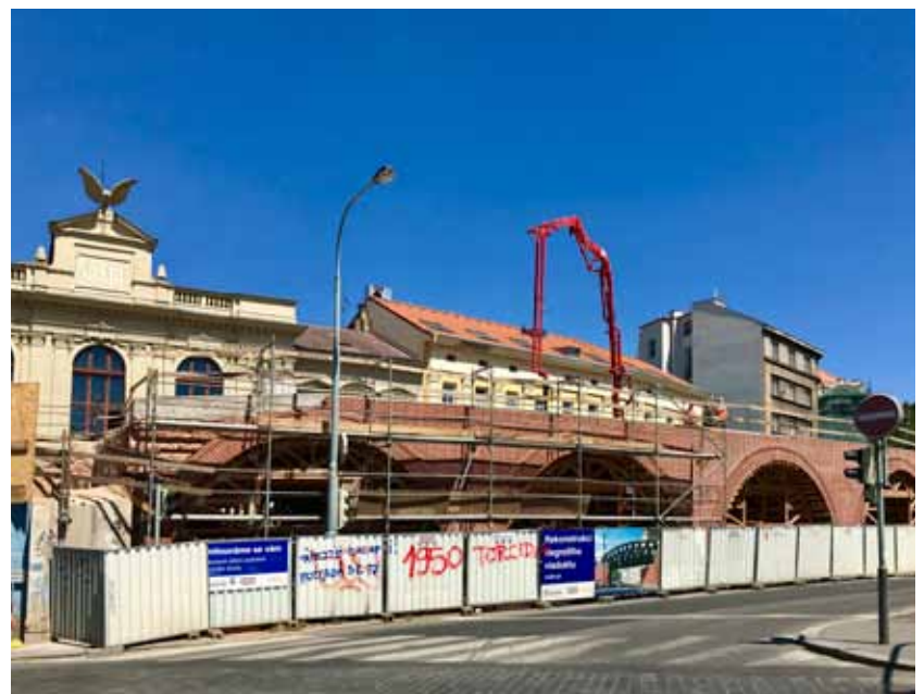
Ukládka provzdušněného betonu pevnosti C 30/37
