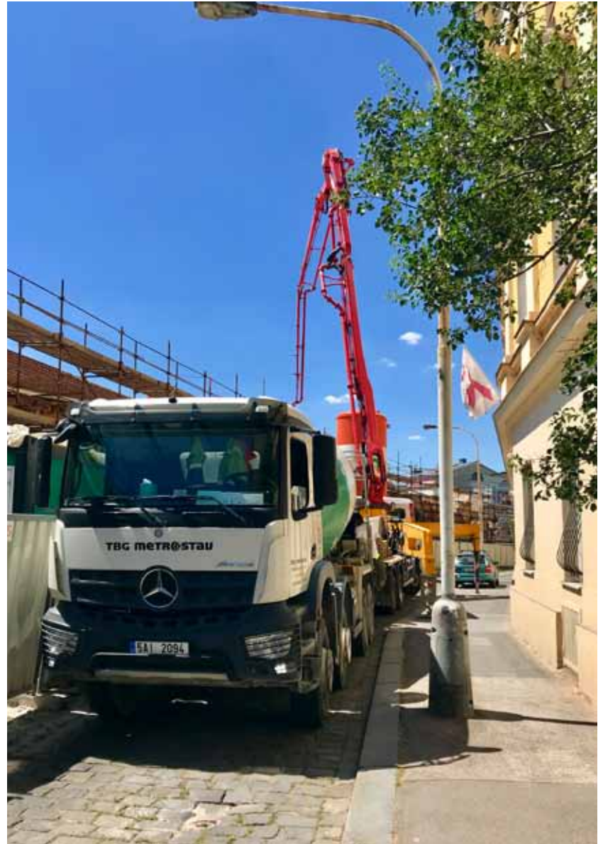
Ukládka provzdušněného betonu pevnosti C 30/37
