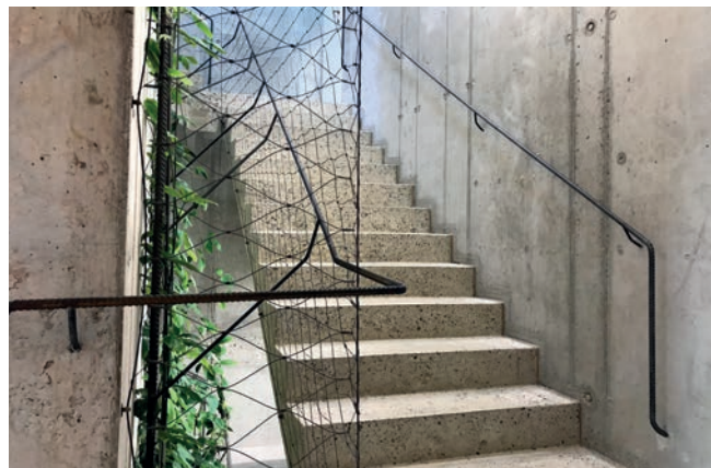
Schody z bílého betonu
