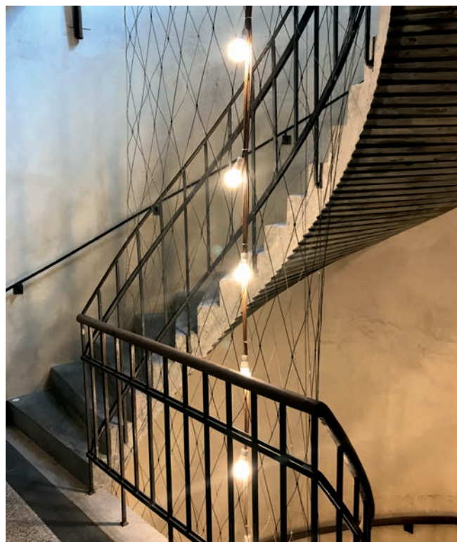
Betonové točité černé schodiště
