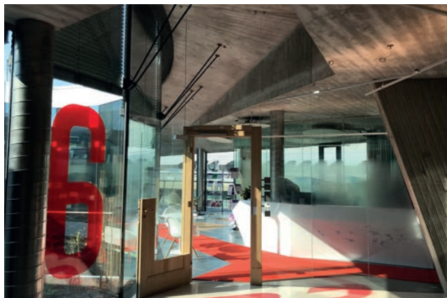
Nezakryté povrchy stropů, stěn a sloupů v horních patrech
