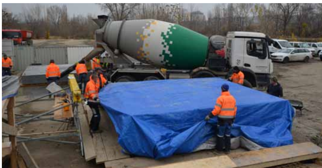
Ošetřování bezprostředně po betonáži segmentů
