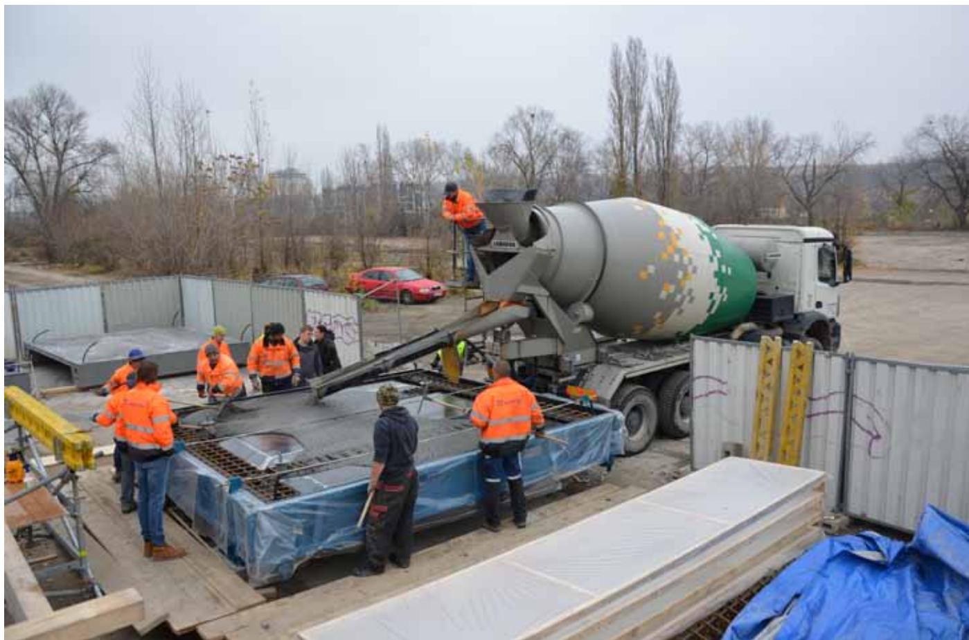
Plnění formy betonem TOPCRETE na Rohanském ostrově
