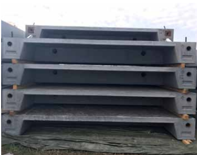
Skládkování segmentů z TOCRETE na staveništi
