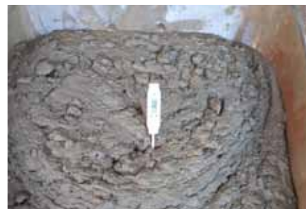
Chlazený beton dodaný na stavbu
