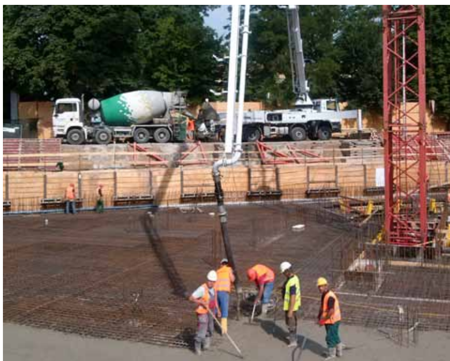
Letní betonáž bytového domu U Uranie
