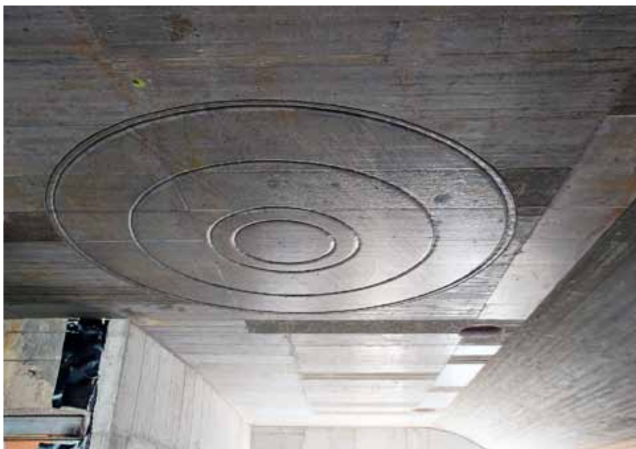
Obrazce na stropěch vznikly pomocí různých typů kabelů lan vložených do bednění
