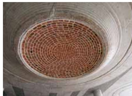
Strop se zabudovanými cihlami
