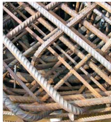
Obr. 11: Detail vyztužení tunelů Národního divadla
