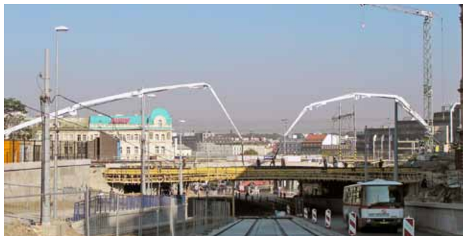
Obr. 1: Betonáž mostu přes Seifertovu ulici
