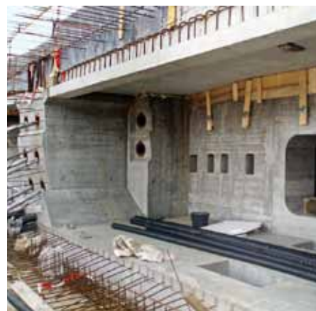
Obr. 5: Nové spojení, detail výztuže
