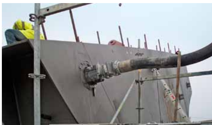
Obr. 12, 13: Betonáž Trojského mostu
