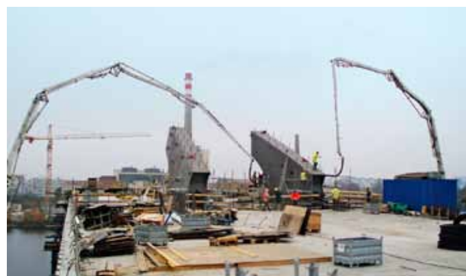
Obr. 10: Betonáž při rekonstrukci tunelů Národního divadla
