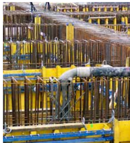
Obr. 5: Nové spojení, detail výztuže
