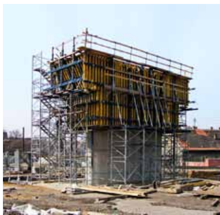
Obr. 6-8: Betonáž konstrukce Nového spojení
