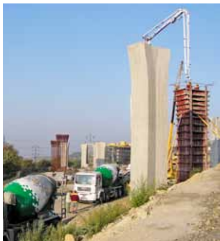
Obr. 9: Betonáž pilířů Novovysočanské estakády
