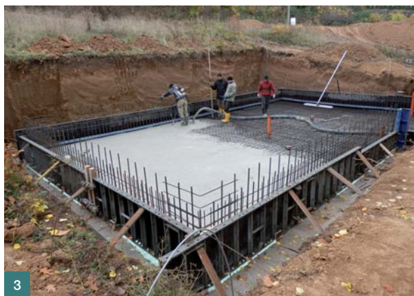
Obr. 4 Připravené bednění pro betonáž stěn bílé vany
